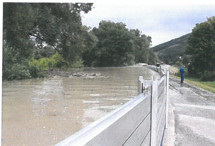
fotografia 18. Mestskú časť Devín chráni v Bratislave mobilná hrádza pred povodňou v roku 2013
